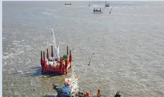
Afbeelding 4-6: Voorbeeld van een HDD-boring (op zee)
