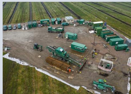
Afbeelding 4-8: Voorbeeld van een werklocatie (HDD-boring) op land
